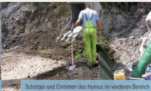
Einbau und Verdichtung der ersten Füllschicht
