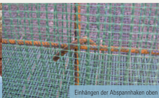
Sorgfältige Verlegung des Erosionsschutzgitters
